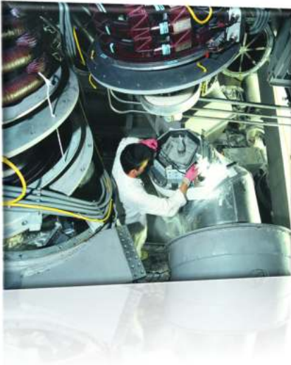
Vorortversilberung im Atomkraftwerk
